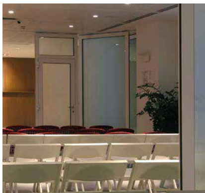
Un dettaglio della porta inserita nell'elemento della parete manovrabile Detail of the door inserted in the element of the movable partition
